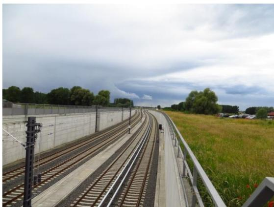
Regionalbahn- und S-Bahn-Gleise westlich der Ausfahrt aus dem Flughafentunnel bei Selchow, im Hintergrund der Bogen mit Übergang in Dammlage, wo die S-Bahn nach links ausfädeln könnte. Für eine niveaufreien Abzweig könnte das Gleis nach Lichtenrade noch im Einschnitt nach rechts abbiegen und weiter hinten den S-Bahn-Damm unterqueren.
